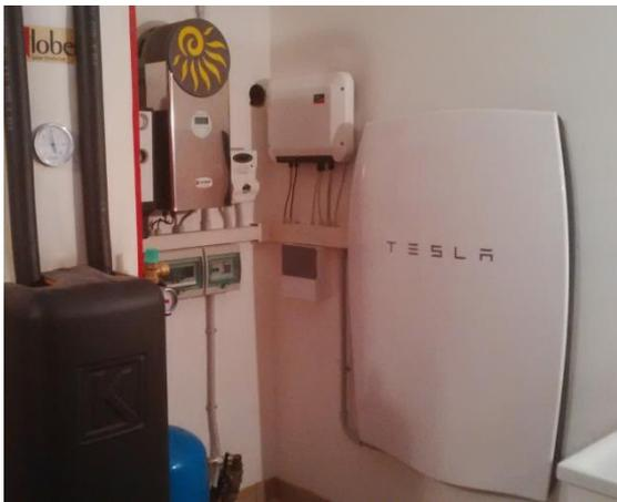
Sistema di accumulo bidirezionale lato produzione con pacco batterie al litio
