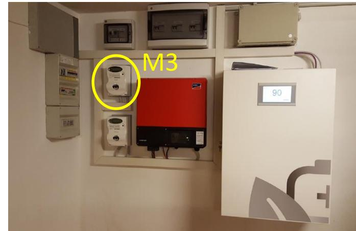
Sistema di accumulo integrato bidirezionale lato post produzione con pacco batterie al litio. Provvisto di contatore M3
