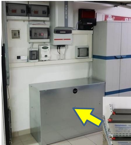
Sistema di accumulo monodirezionale lato produzione con pacco batterie al Pb
