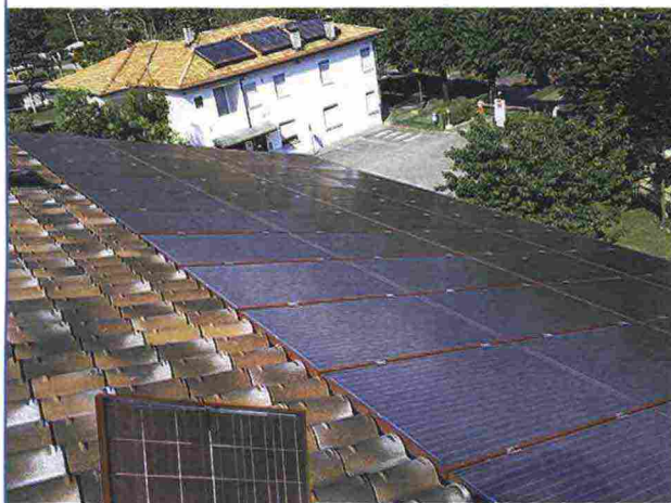
L'innovativo modulo fotovoltaico policristallino a celle rosse di Brandoni Solare è costituito da 60 celle 15,6x15,6 cm e ha una potenza di 225W.
